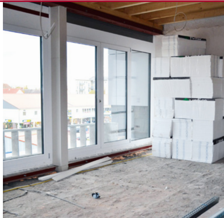
Vorbereitet werden Deckendämmung und Fußbodenarbeiten, die Materialien liegen in den Zimmern bereits bereit.
