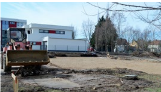
Vorbereitung der Fläche für die Bodenplatte
