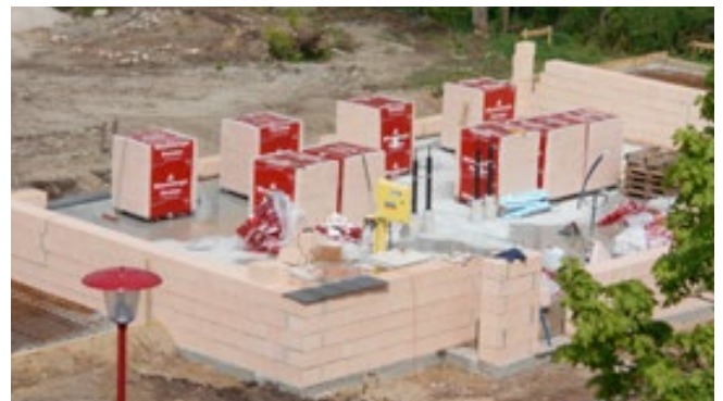
Der Rohbau für das neue Doppelhaus
