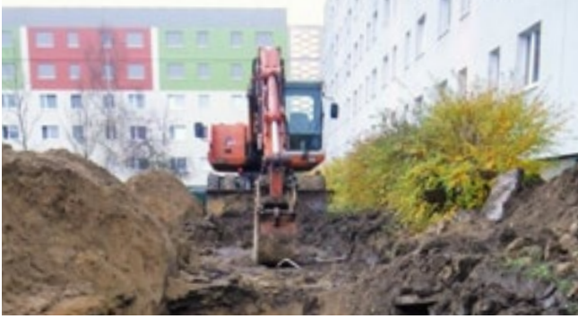
Umverlegung der Abwasserleitung
