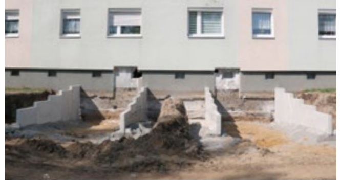
Herstellung der neuen Kellereingänge
