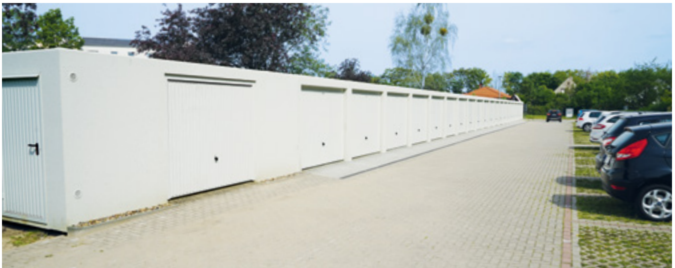
Bereits seit Dezember steht der neue Garagenkomplex in der Othrichstraße und bietet Platz für 22 Fahrzeuge.
