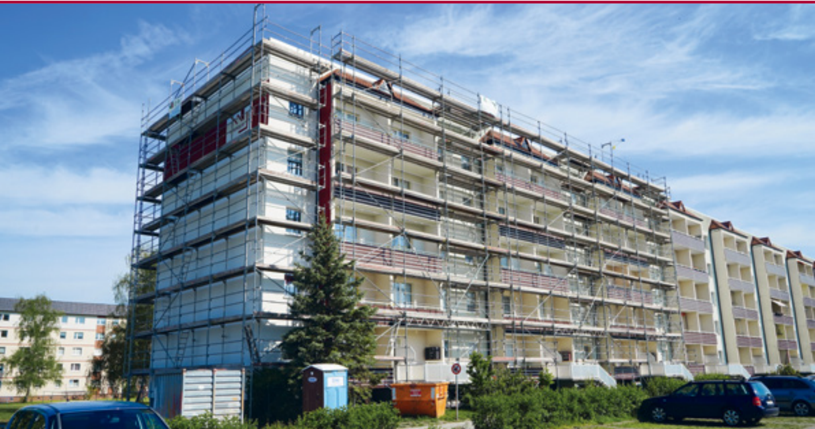
Eingerüstet und bereit für die Reinigung und einen neuen Anstrich: das Gebäude in der Othrichstraße.
