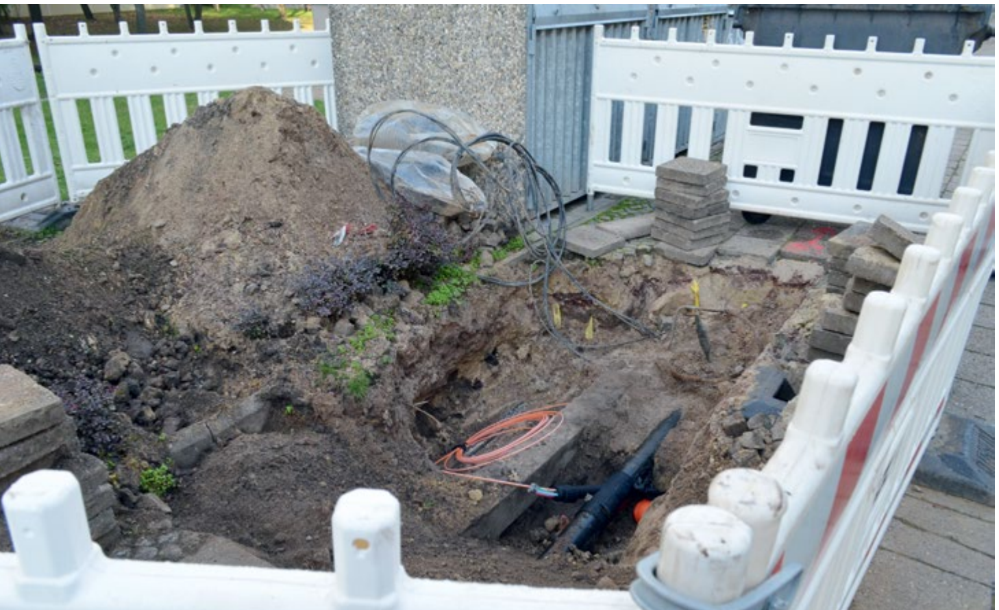
Bauarbeiten für den Glasfaserkabelanschluss in der Brunnerstraße.
