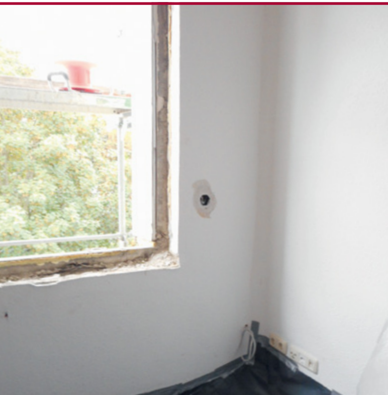
Für den Zugang zum Balkon muss ein Fenster entfernt werden.
