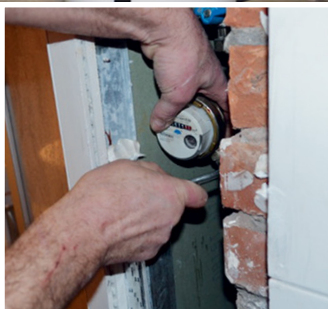
In den Kellern wurden neue Heizungsanlagen installiert (Foto oben), in den Wohnungen die Wasserzähler ausgetauscht.
