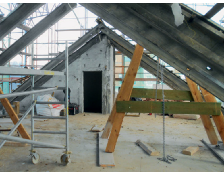
Das alte Dach wurde abgetragen.
