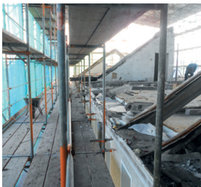
Gerüststützen stabilisieren das Überdach.
