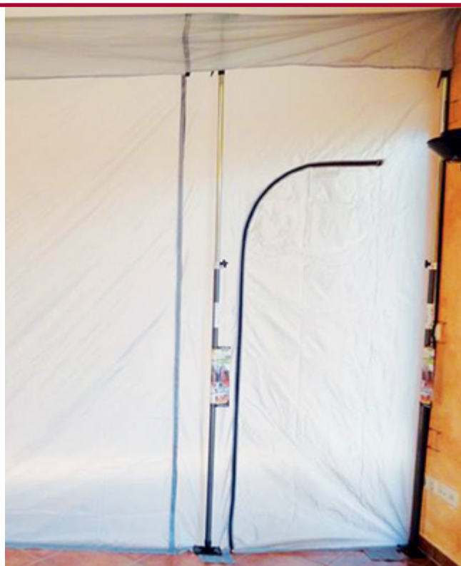
Staubschutzwände schützen vor Schmutz.
